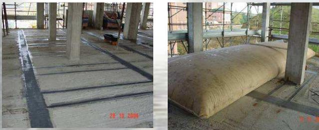
CONSOLIDAMENTO DI UN SOLAIO LATERO-CEMENTO CON L'AUSILIO DI LAMELLE E FIBRE DI CARBONIO
