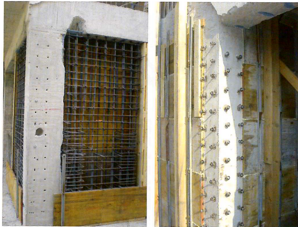
Figura 7 Armatura dei setti di nuova realizzazione e collegamento con i pilastri esistenti.
