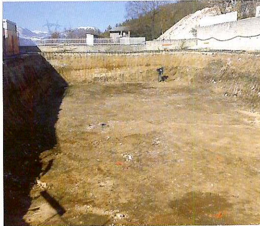
Figura 13 Demolizione degli edifici (a sinistra).
