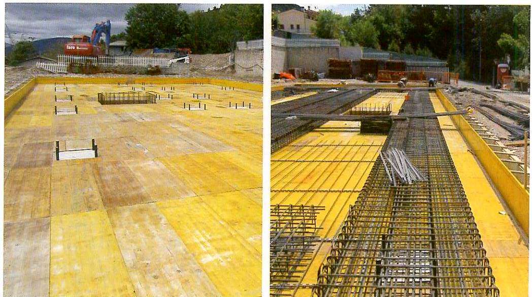
Figura 23 Armatura della platea della sovrastuttura in corrispondenza degli isolatori.
