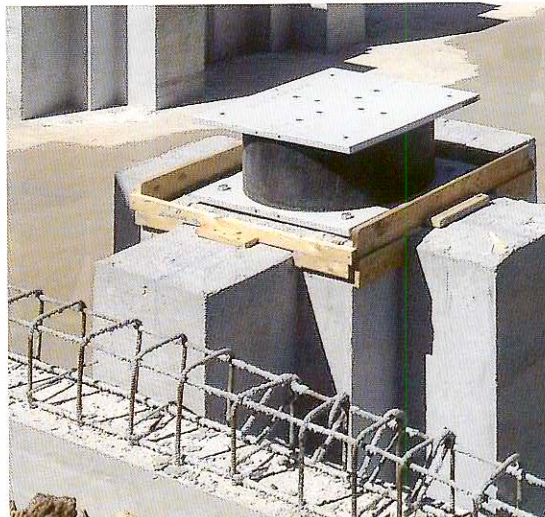
Figura 21 Casseratura in testa ai pilastri e getto di completamento al di sotto della base degli isolatori.
