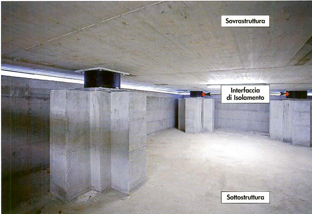
Figura 24 Interfaccia di isolamento completata.
