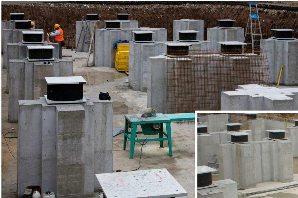
Durante la **fase di posizionamento** degli isolatori sui pilastri si sono utilizzati dei cunei e delle viti di livellamento per garantire il livello altimetrico e la perfetta orizzontalità dei dispositivi.
