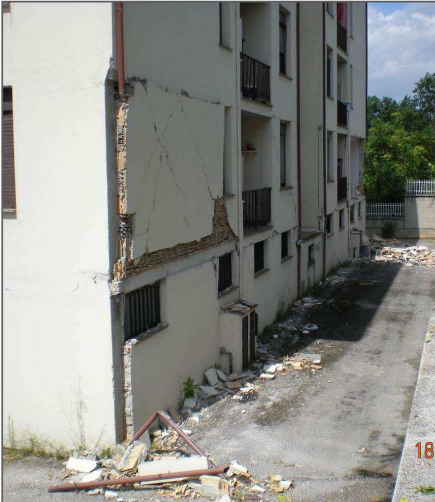
Presenza di fratture ad andamento orizzontale in corrispondenza dei solai di piano indice di un distacco dei tamponamenti dalla struttura portante.
