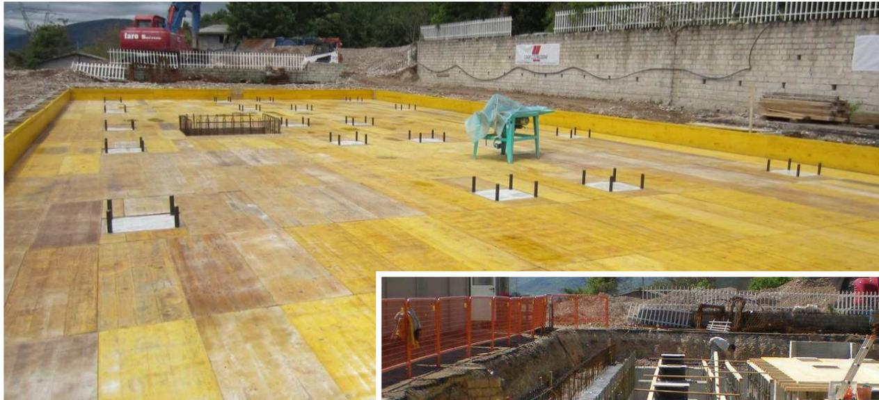
Per quanto attiene al **collegamento con la sovrastruttura**, il calcestruzzo è stato gettato direttamente sugli isolatori già posti in opera e muniti di zanche d'ancoraggio superiori.
