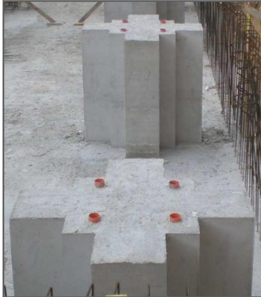
Prima di effettuare il getto dei pilastri della sottostruttura sono stati predisposti gli **alloggiamenti** necessari per le **zanche di ancoraggio inferiori** degli isolatori.
