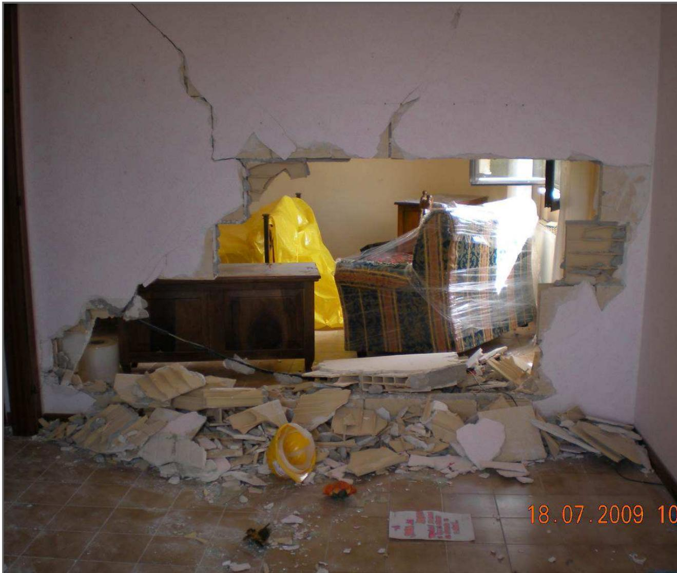
Fenomeni deformativi ben evidenti anche sui tamponamenti interni ed esterni: le lesioni più diffuse si sono rilevate in corrispondenza delle aperture e maggiormente gravose in corrispondenza del primo piano con andamento a croce o inclinato con espulsione parziale o totale localizzata di materiale.
