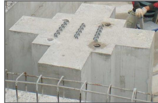
Il getto della sottostruttura è stato effettuato sino ad una quota di circa 3 cm al di sotto della quota di intradosso della piastra inferiore degli isolatori.
