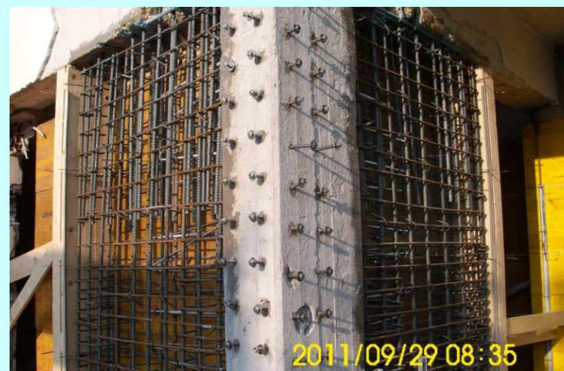
Armatura setti di rinforzo
