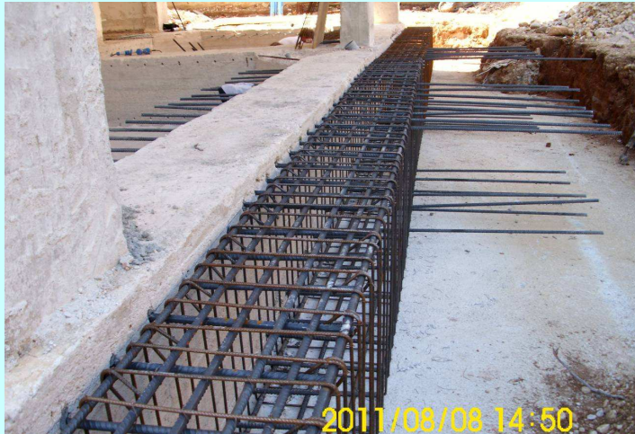
Armatura rinforzo fondazioni esistenti
