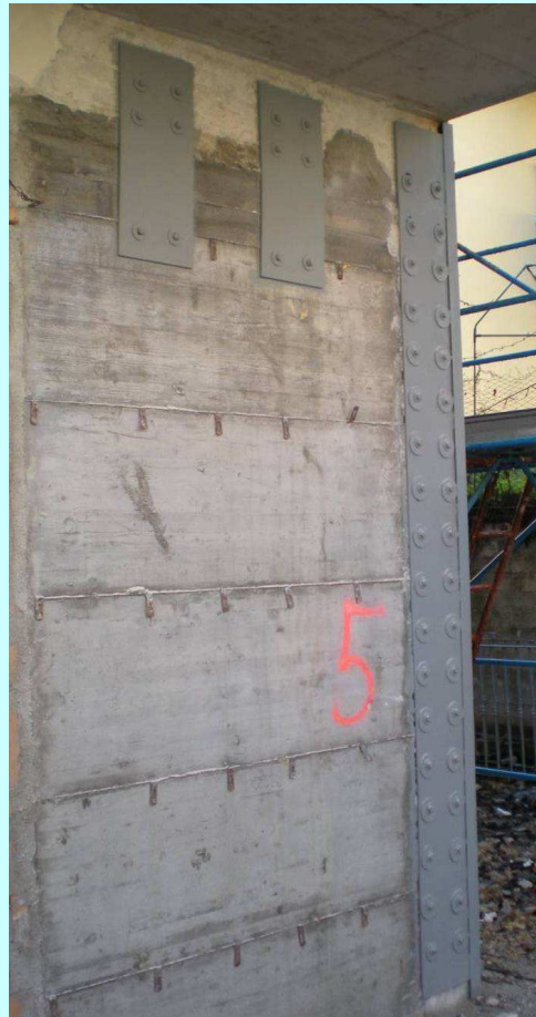
Piastre di confinamento dei setti e delle travi
