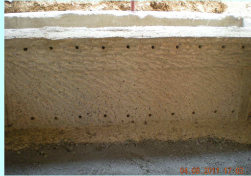
Scarnifica delle fondazioni esistenti
