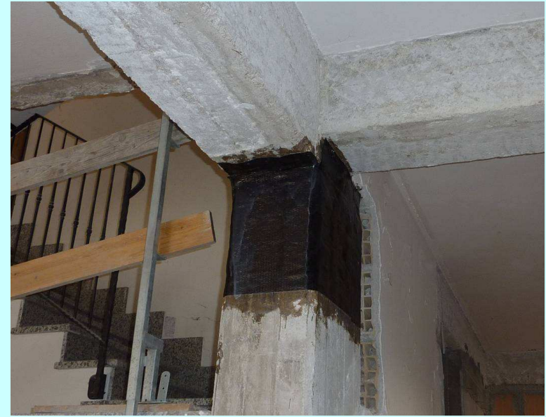
Rinforzo dei nodi con fibre di carbonio
