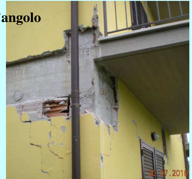
Danno ai tamponamenti interni
