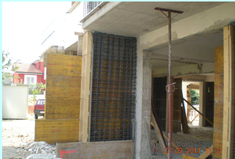
Armatura setti di rinforzo
