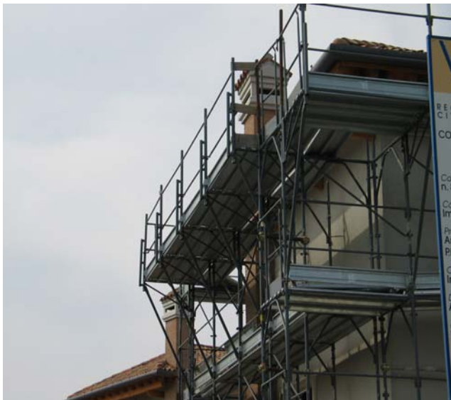
Figura 11 – Sbalzo per lavori su lina
