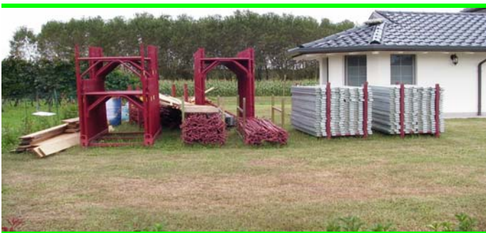
Fig.9 Deposito ponteggio a telai prefabbricati
