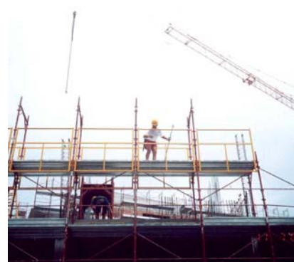
posa correnti parapetto
