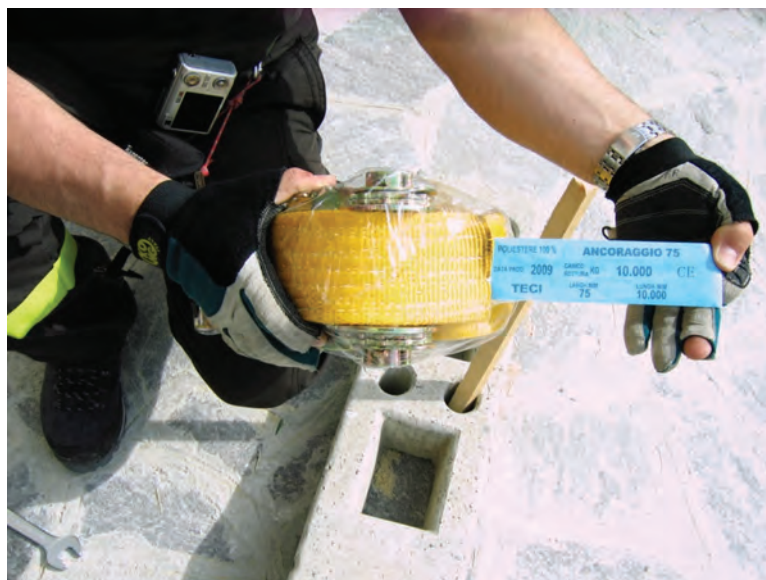
Fasce in poliestere impiegate per la tirantatura.
