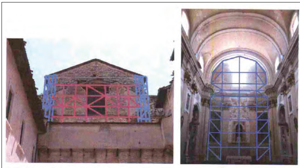
Configurazione geometrica del graticcio ipotizzato (Archivio NCP).
