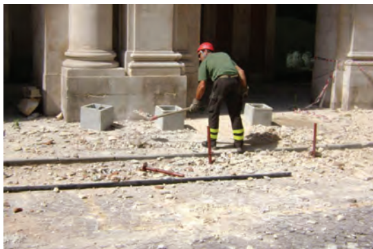
Pulizia del cantiere dalle macerie (Archivio NCP).
